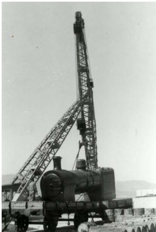
Grúa Derrick descargando una máquina de tren. Autor desconocido, s.d. Archivo General del Puerto de Vigo . Reg. 00317 y 00318
